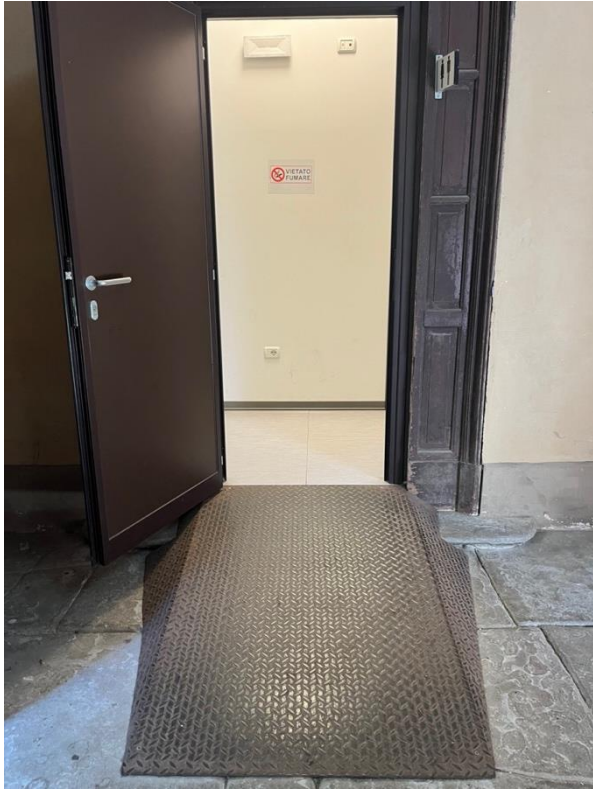
Assenza di spazi di manovra per l'usabilità in autonomia
