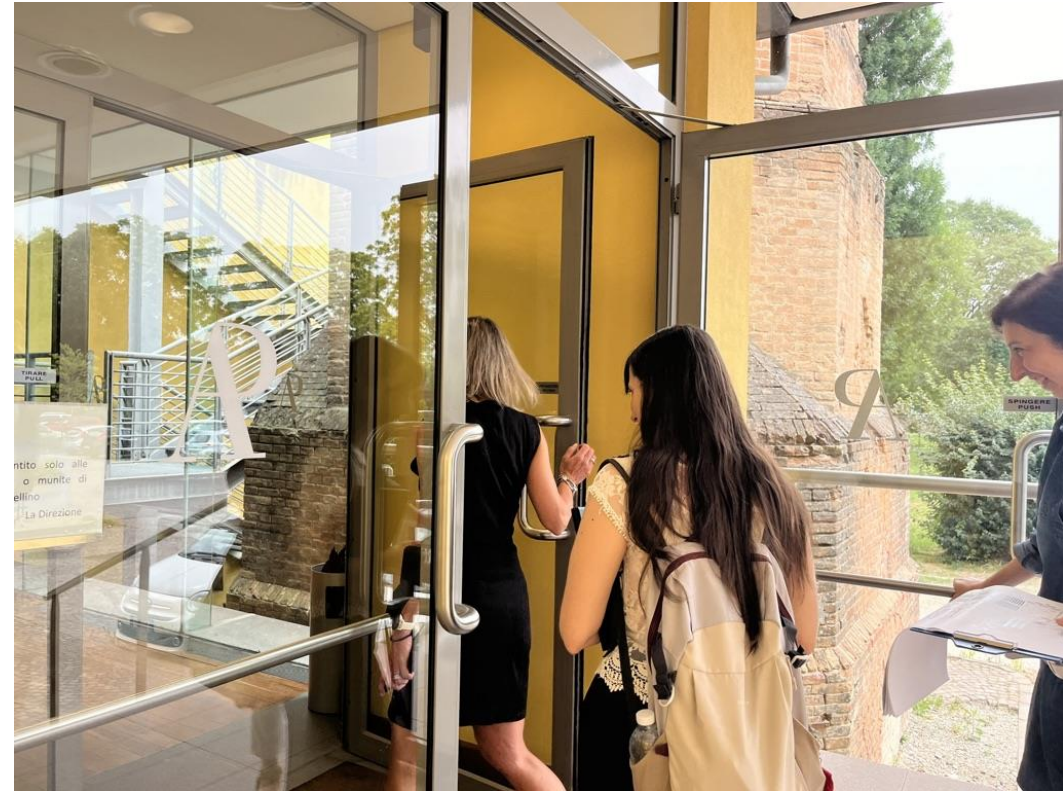
Profondità della bussola insufficiente per l'usabilità in autonomia
