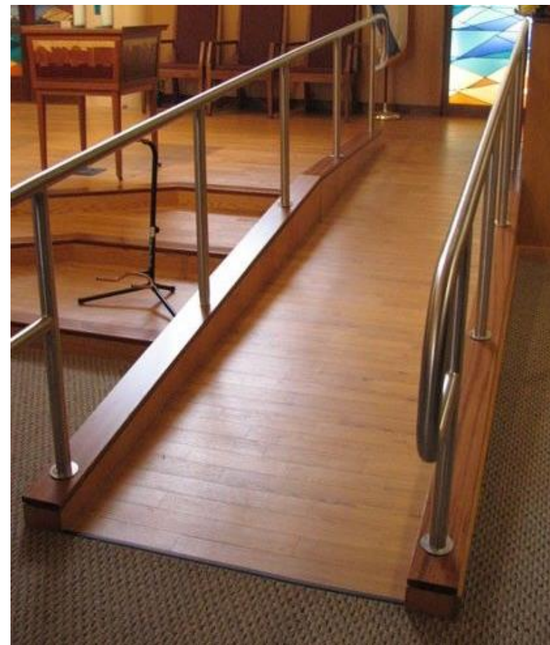
Rampa con ferma ruota e corrimano
