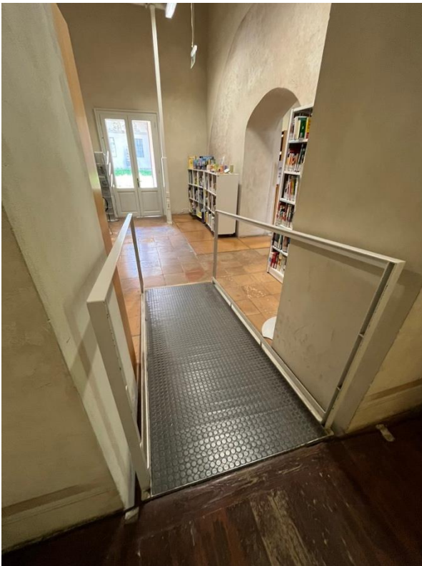
Rampa a pendenza contenuta
